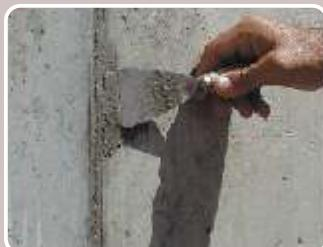
От външната страна се премахва стърчащата арматура и укрепители, на дълбочина 3 см в бетона с помоха на перфоратор. Следва намокрянето на тези места и запълването им с **DUROCRET**. Със същия материал се запълват десортирания бетон и работните фуги след като са отворени конусовидно предварително на 3 см дълбочина.
