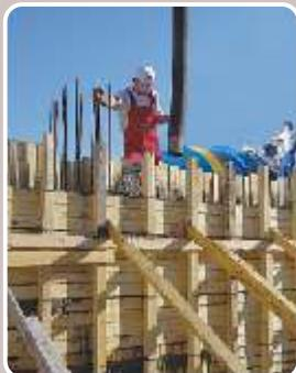
Във фазата на полагане на бетона, се препоръчва добавяне в бетона на добавката за водоплътност и пластификация **PLASTIPROOF**.
